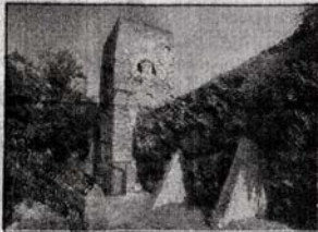
La torre romana e poi medioevale
